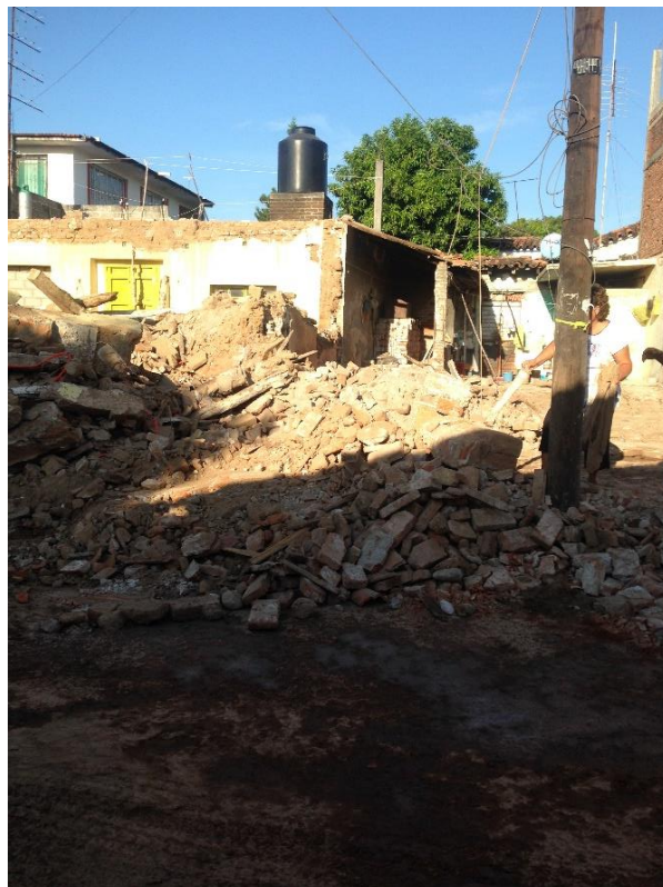
Situación post sismo en la Zona del Istmo de Tehuantepec.
